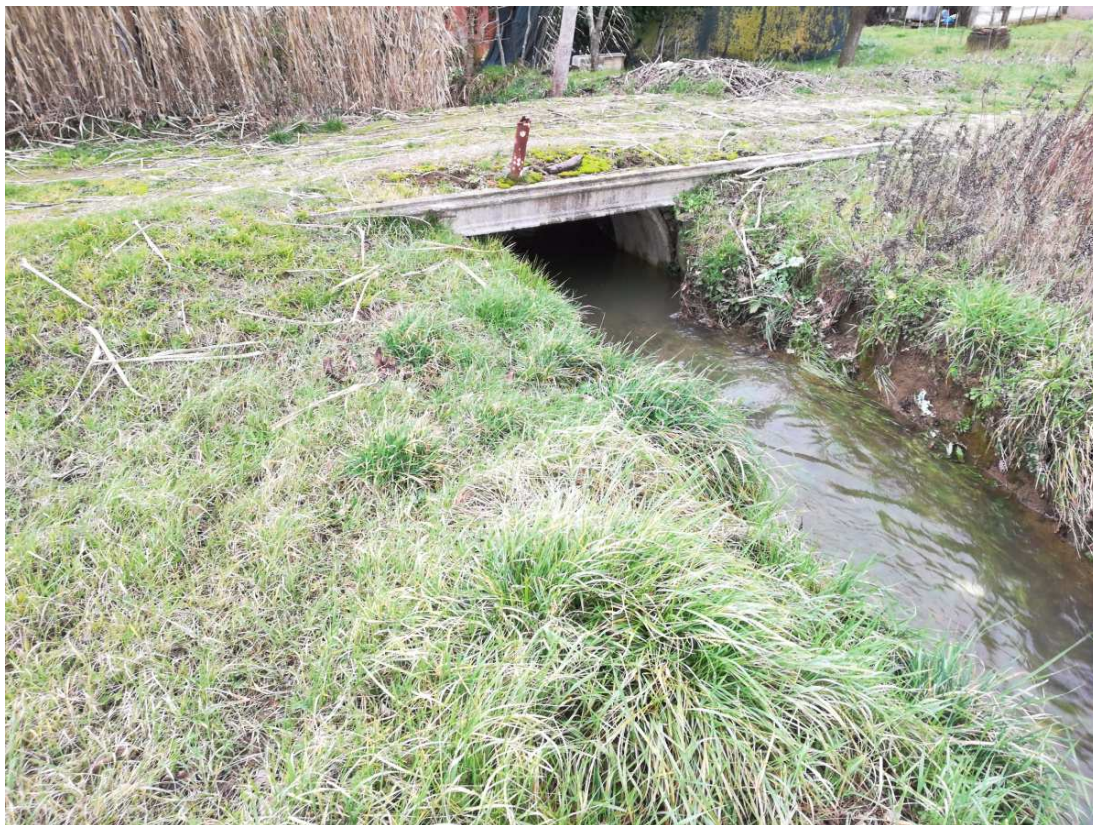
Fig. 3.5 – Sotto attraversamento di una strada rurale nel tratto di monte del Gavardello
